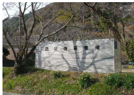
鋸東コミセンの防災備蓄倉庫
