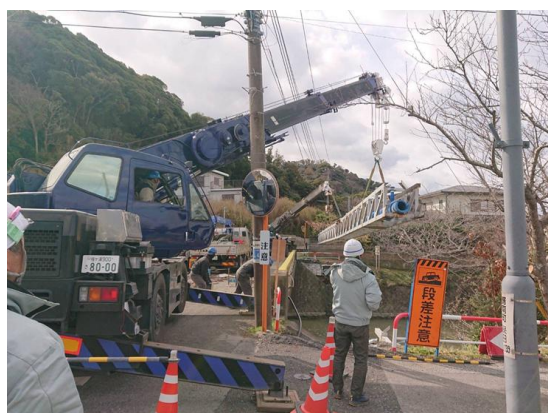
水管橋の更新
