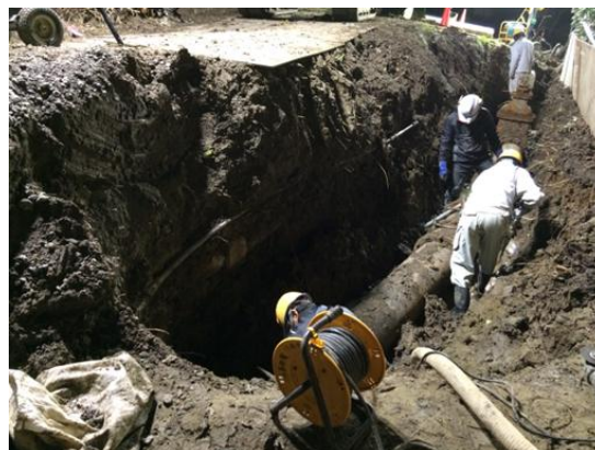
老朽化した管路の更新
