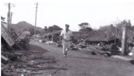
関東大震災で被災した保田地区
