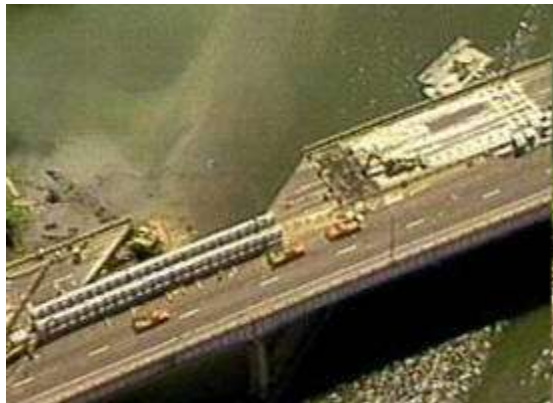
写真-1 マイアナス橋の落橋
