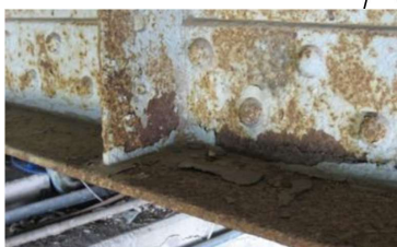
主桁の腐食
