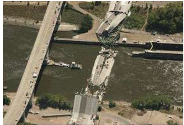
写真-2 I-35W橋の落橋（ミネアポリス橋梁）
