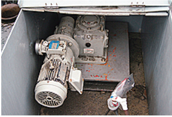
修繕を予定している浄水場混和池攪拌機
