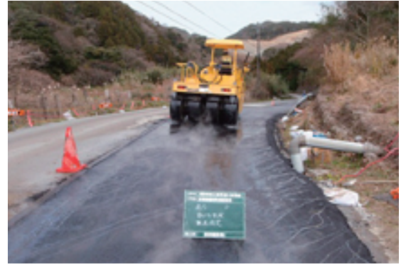
水道管が埋設されている町道 1-106 号線（横根地区）
