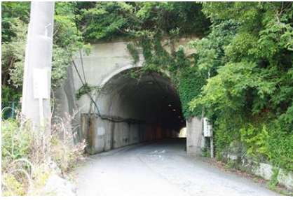
岩井袋トンネル
