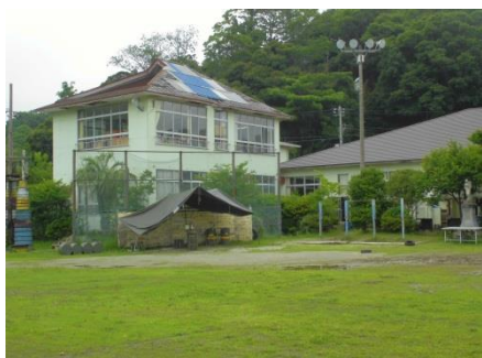
取り壊される特別教室棟
