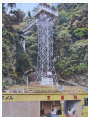
大黒山エレベーター
