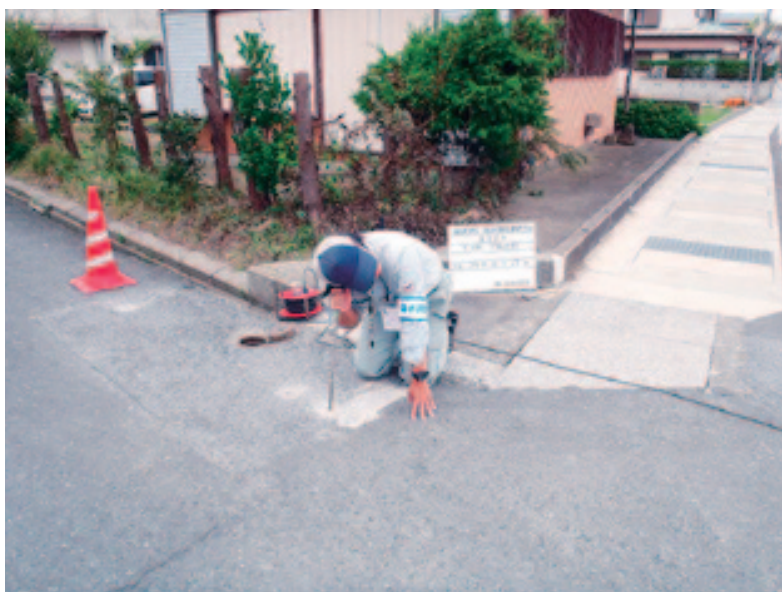
水道漏水探査
