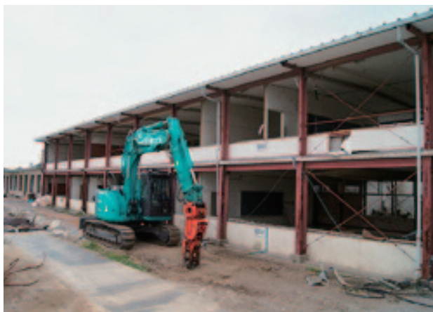
勝山小学校管理特別教室棟解体
