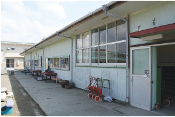
老朽化の進んだ旧勝山幼稚園舎
