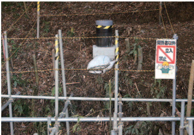
温泉掘削現場（中佐久間地区）
