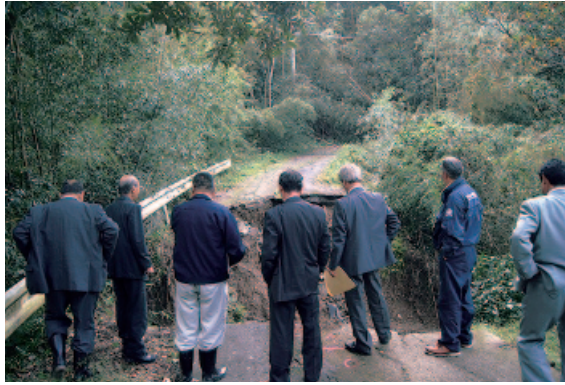
道路陥没現場（川籠線）
