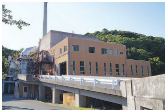
現在稼働しているゴミ焼却施設
