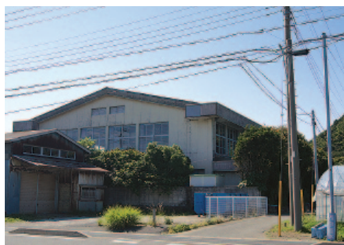
直売所へ改築される旧保田小体育館
