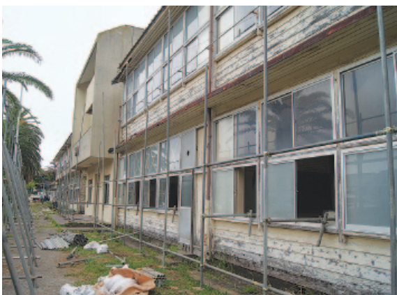
解体工事を行っている旧一中校舎
