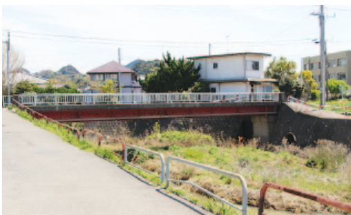
補修工事が予定されている学校橋
