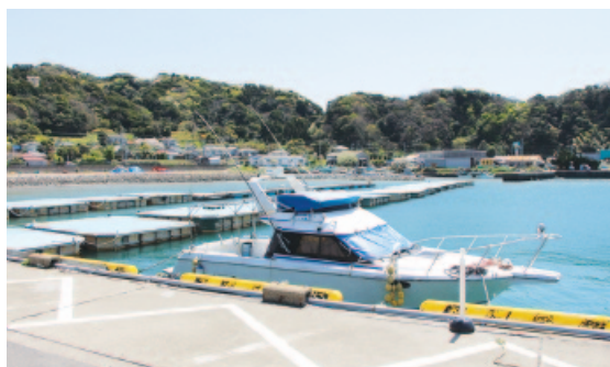
保田漁港浮棧橋
