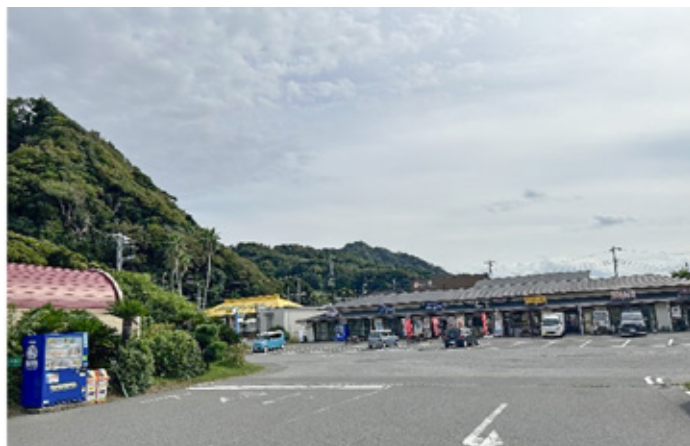
改修が待たれる道の駅きよなん
