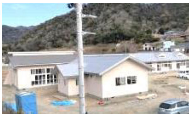
工事が進む旧幼稚園舎
