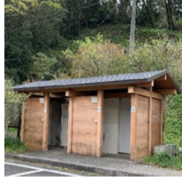
佐久間ダム南側トイレ
