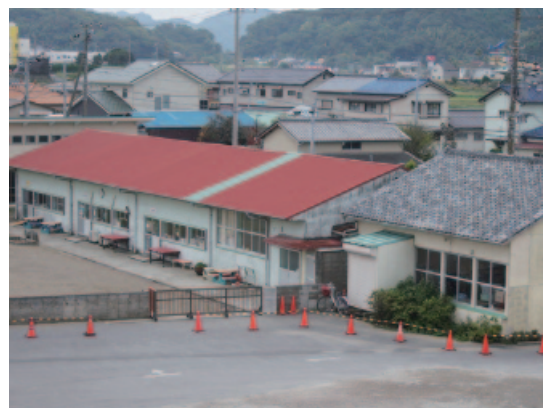
老朽化が進む旧勝山幼稚園園舎
