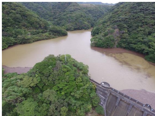
貯水量15万トンの鋸山ダム
