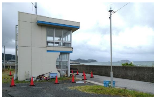
解体予定の保田海岸の監視所
