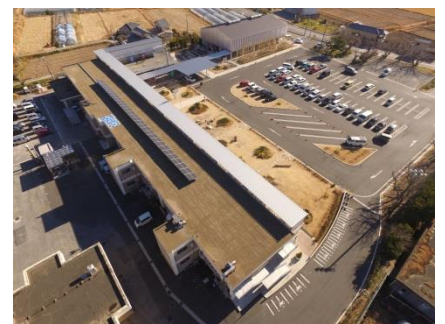
改修予定の道の駅保田小屋上
