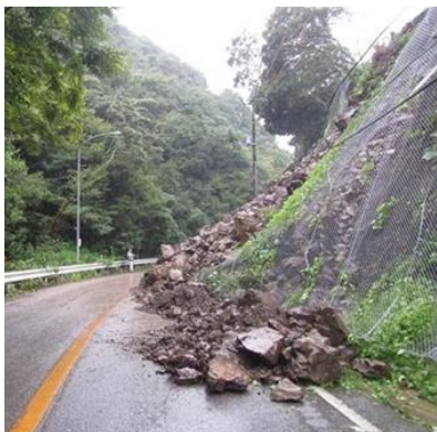
崩落事故直後の現場
