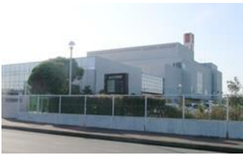
事務所が置かれた木更津市クリーンセンター
