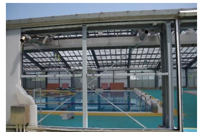
11月改修を完了する海洋センター
