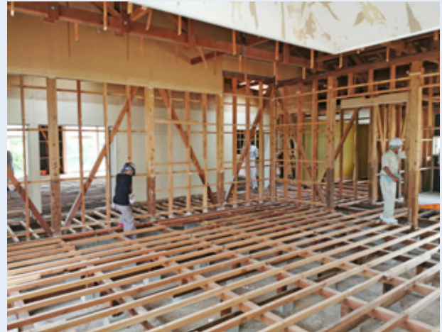
▲園舎内の解体の様子
