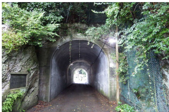
(内宿トンネル)
