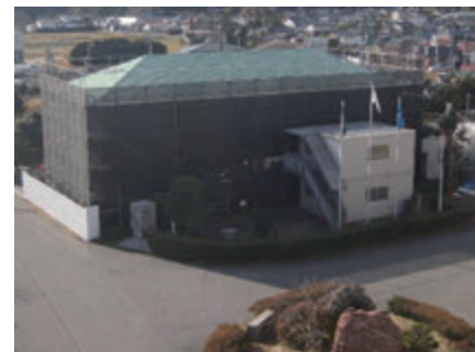
3月中に改修が完了する第1分団詰所
