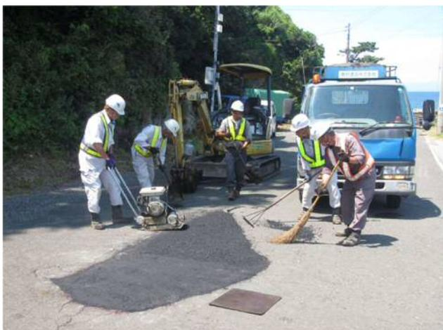
7月10日、公共施設整備のボランティアとして奥村建設株式会社が、鋸南町大六地区で道路の舗装補修工事を行いました。作業員7名により、午前9時から正午まで行われ、合材2トン、2トンドンプ3台、重機1台及び転圧ローラ等を使用し、熟練された手作業でアスファルト合材を丁寧に均し、路面をきれいに仕上げていきました。
