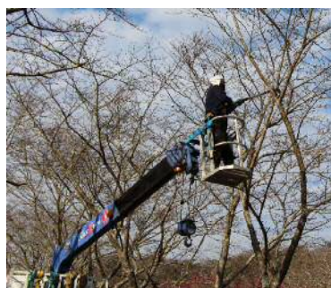
高所作業車での作業
