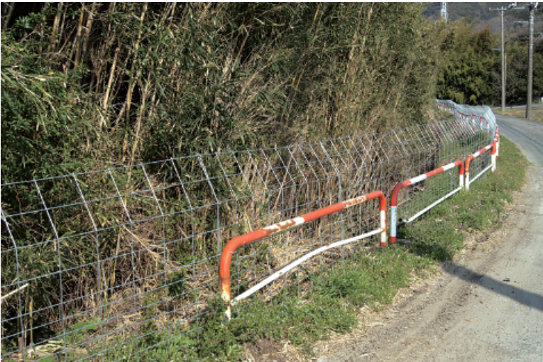
物理柵設置（赤伏地区）
