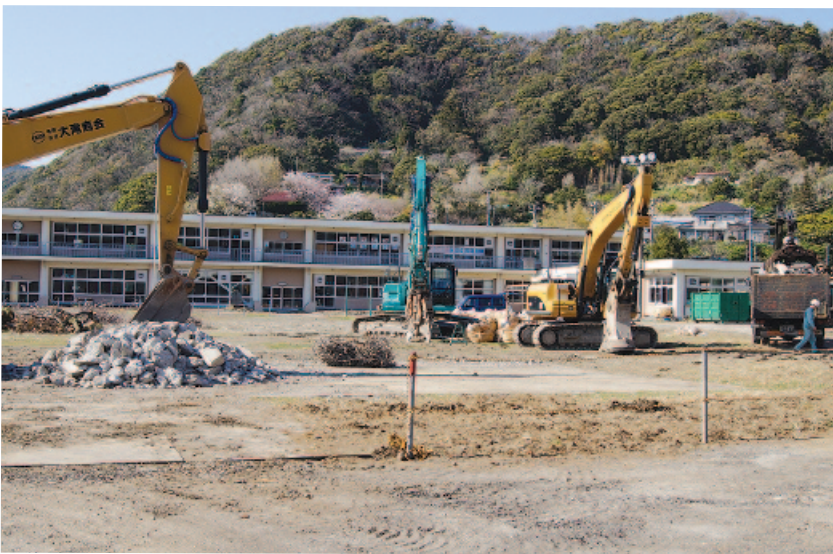
改修が始まった旧保田小学校
