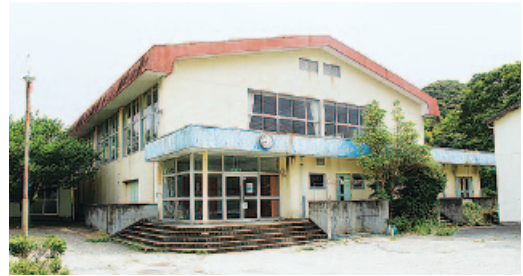
耐震診断が必要な旧佐久間小体育館
