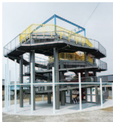
津波から命を守る避難タワー (イメージ写真)
