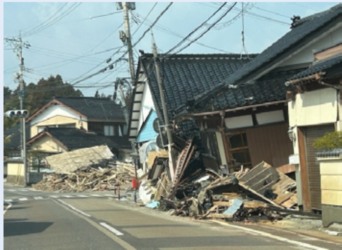
▲倒壊した家屋
